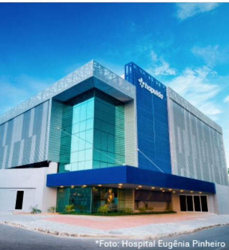
*Foto: Hospital Eugênia Pinheiro
